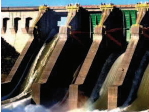
Figura 7. Usina hidrelétrica de Salto Santiago (fonte: g1.com.br)
