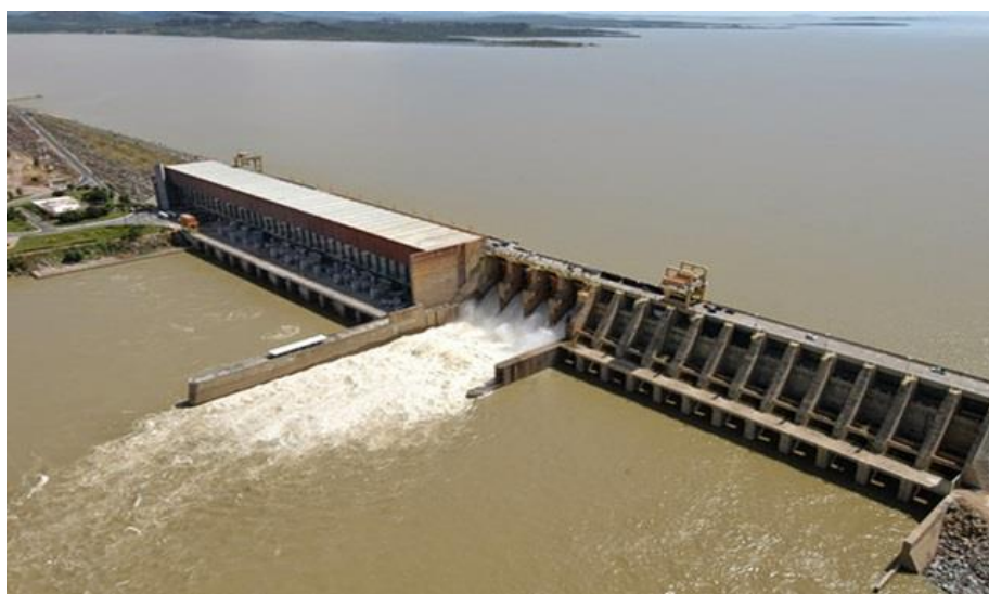
Figura 10. Usina Hidroelétrica de Sobradinho
